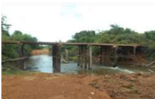
Imagens 10 - Ponte sobre o rio Capivarí
